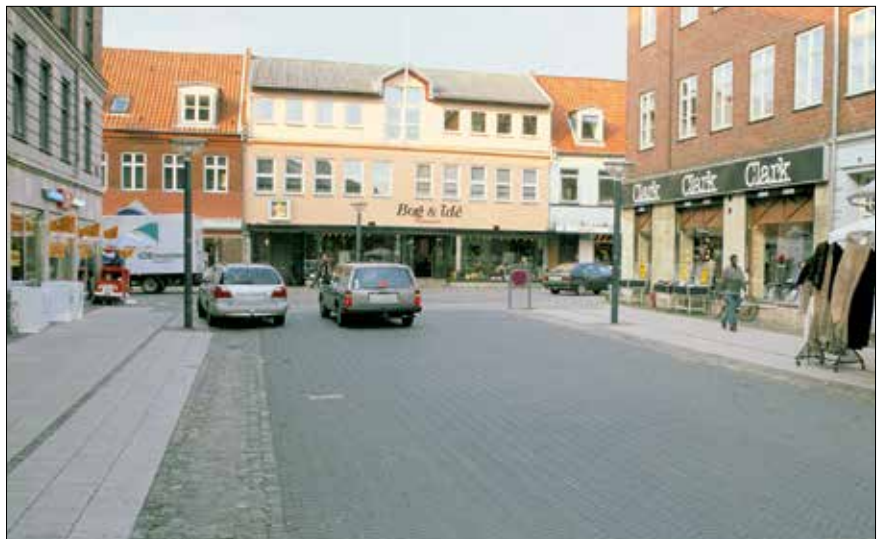
Med vejbane og fortov i samme niveau har man med et bånd af chaus-sésten som markering skabt en mellemting mellem at adskille og blande biler, cykler og gående i denne bymidte. Etableret i 1992 – 1994 (Ringsted).
